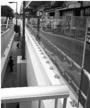
設置された転落防止柵
