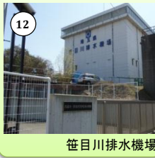
排水ポンプの改築事業
