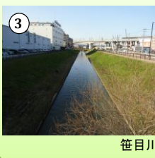
河川護岸の改修事業
