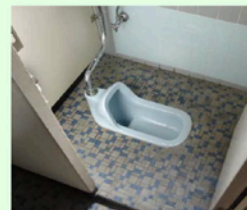
【改修前】共用トイレ
