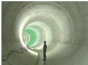
直径6メートルの貯留管を整備
