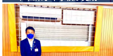
全小中学校体育館へエアコン設置
