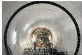
初期掘進状況
