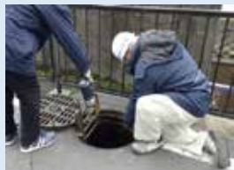
地上からの点検
